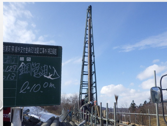
『 道路抑止杭工事 』
