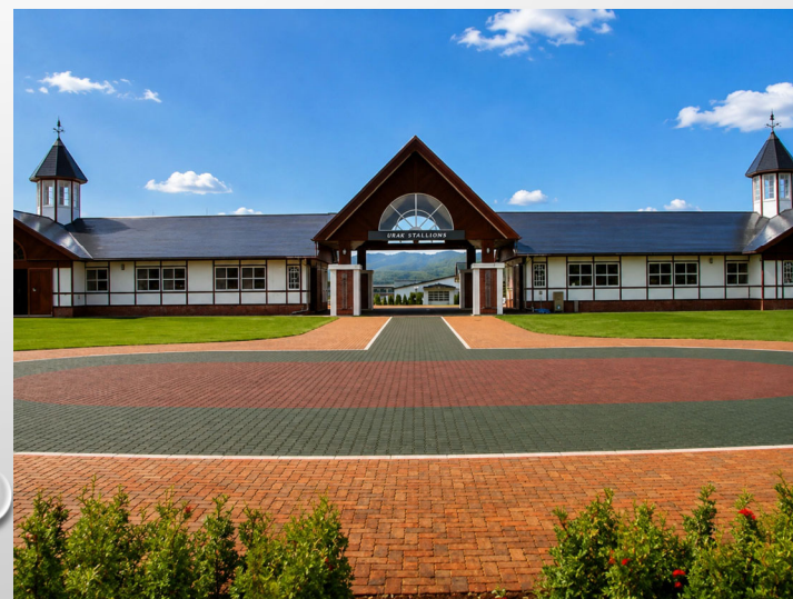
( 民間土木 ) 『 外構工事 』
