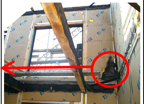
外壁面ウレタン® 材補修後、再使用可
